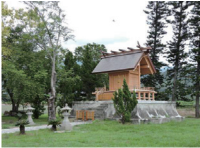
再建された、台湾・旧台東鹿野村社
