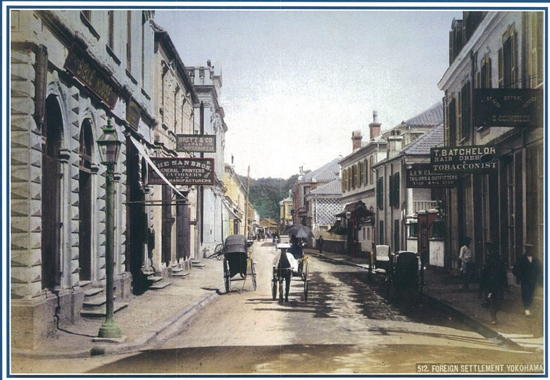
明治中期の山下居留地 80 番付近 (横浜開港資料館所蔵 彩色写真)
